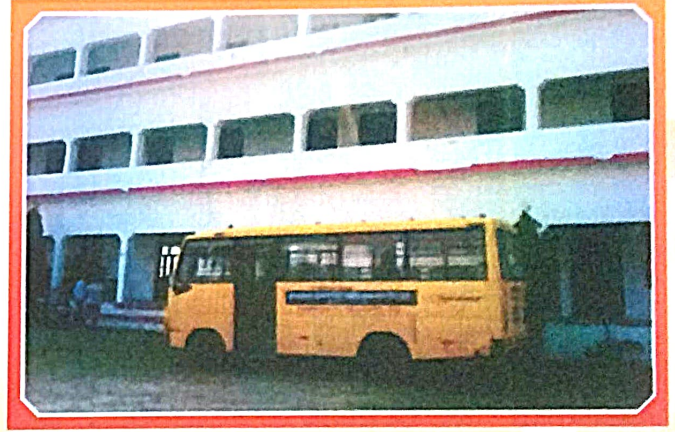
जगदम्बा शरण सिंह एजुकेशनल इंस्टीट्यूट, बेलसर-गोण्डा
